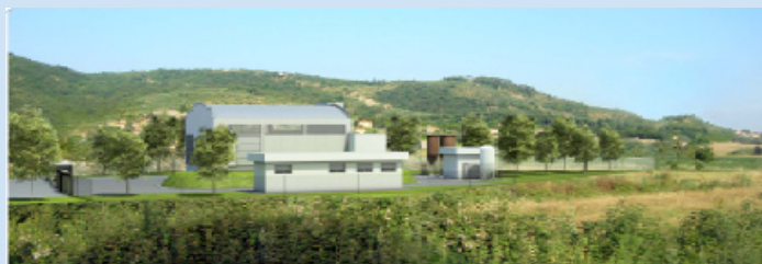
Impianto di potabilizzazione loc. Vallone, Cortona
